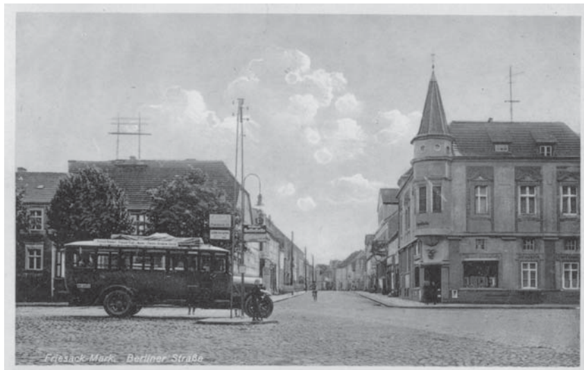
Die Apotheke nach der Aufstockung und Umbau
